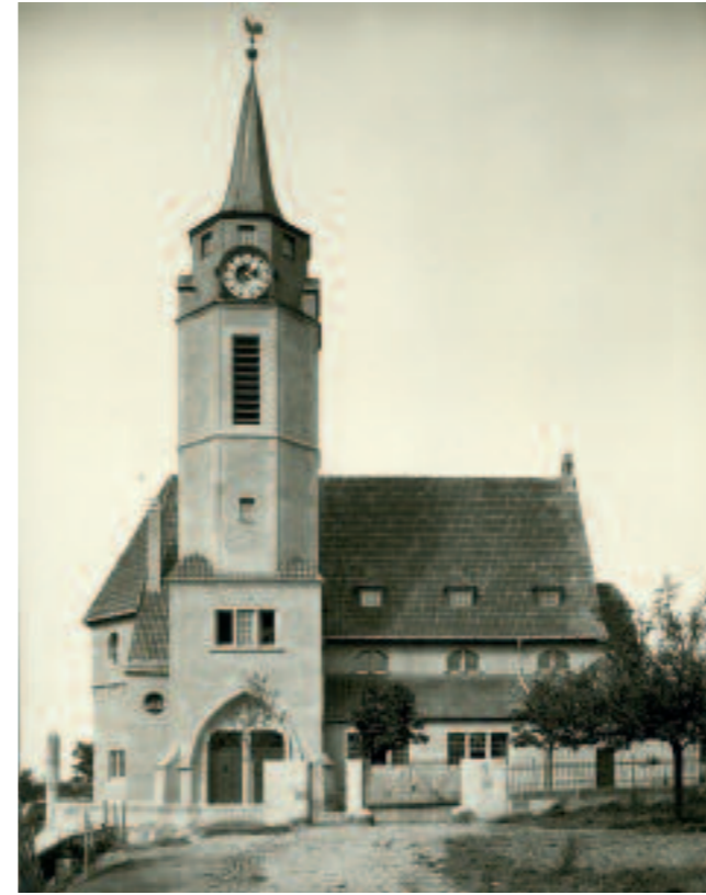
Pfarrkirche St. Georg in Massenbach, 1913
